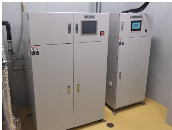
ユニット例（1500W・5000W） 生成装置、微酸性電解水タンク、 供給ポンプを有します。
